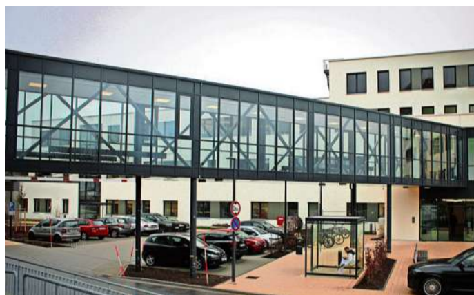
Der „Skywalk“, der Alt- und Neubau des Klinikums verbindet, war für den Umzug praktisch.
